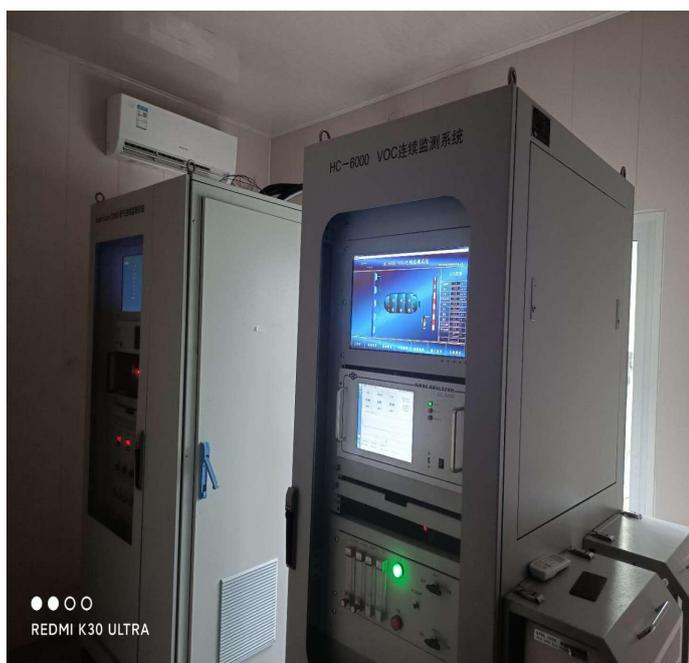
图 3.2.11-8 RTO 焚烧炉废气在线监控系统
