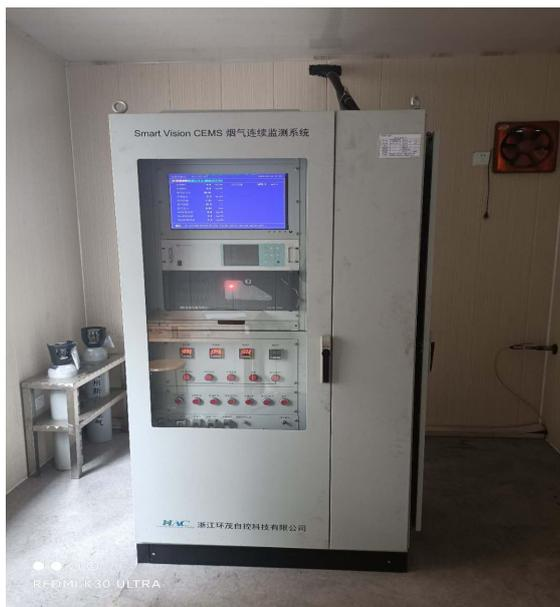
图 3.2.11-10 固废焚烧炉废气在线系统
